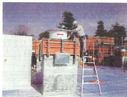
免震装置施工の様子
