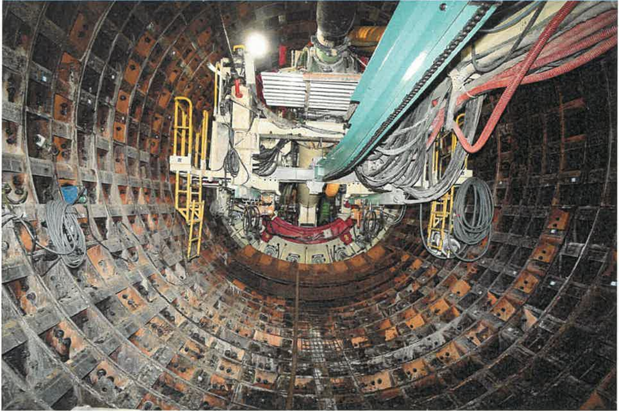
1-③ 地下河川築造工事（掘削状況、シールドマシン裏側）
