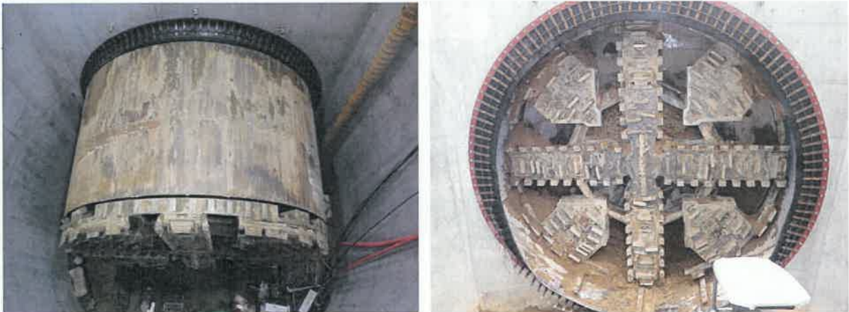
令和2年3月にシールドマシンが到達立坑に到達
