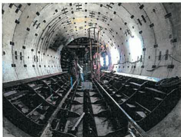
型枠組み立て状況
