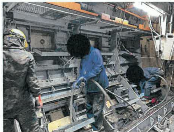
コンクリート打設状況
